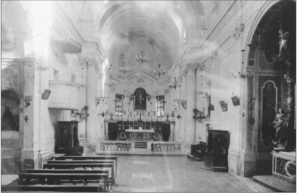
Chiesa San Francesco restaurata - 1947
